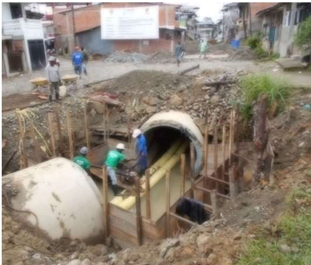
Ilustración 1. Canalización Quebrada La Chanflana Barrio 12 de abril e Independencia, Año 2019
