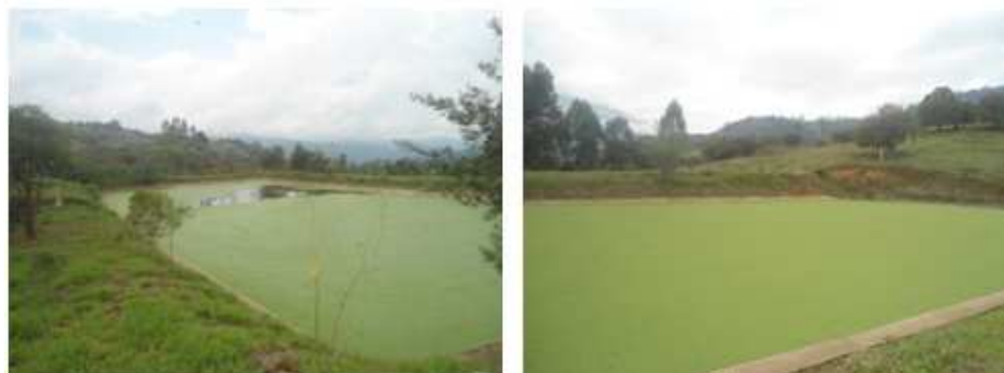
Figura 3-2: Laguna de Oxidación de la PTAR en el municipio de Chinavita
