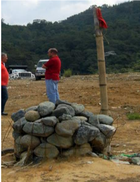
Figura 7. Chimenea actual del relleno sanitario para drenaje pasivo del biogás del relleno sanitario La Esmeralda, Manizales, 2012.
