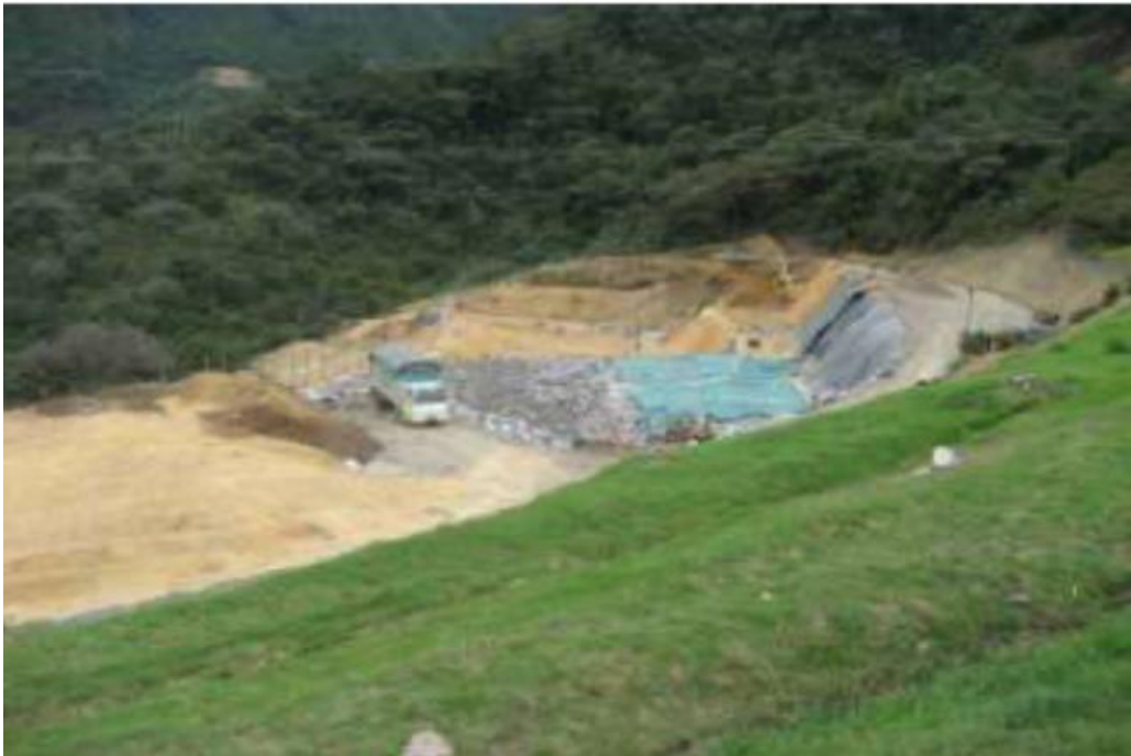
Fuente: Relleno Antanas Pasto – EMAS, 2011.
