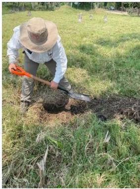
c) Retiro de la capa vegetal y excavación de escalones.
