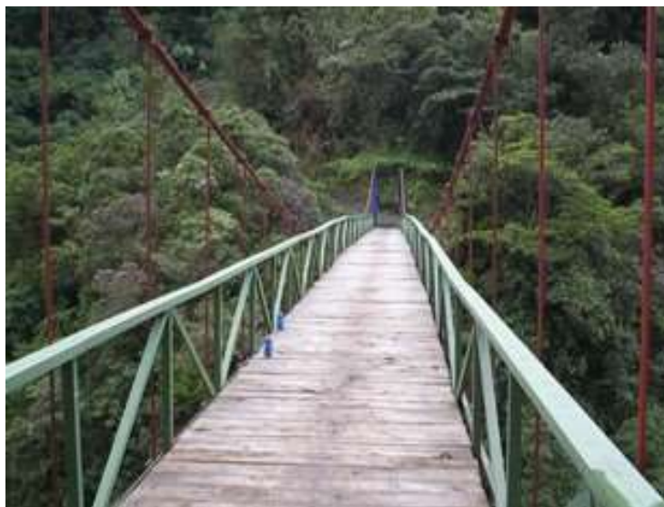
Figura 18 Puente sobre Río Patoyaco.
