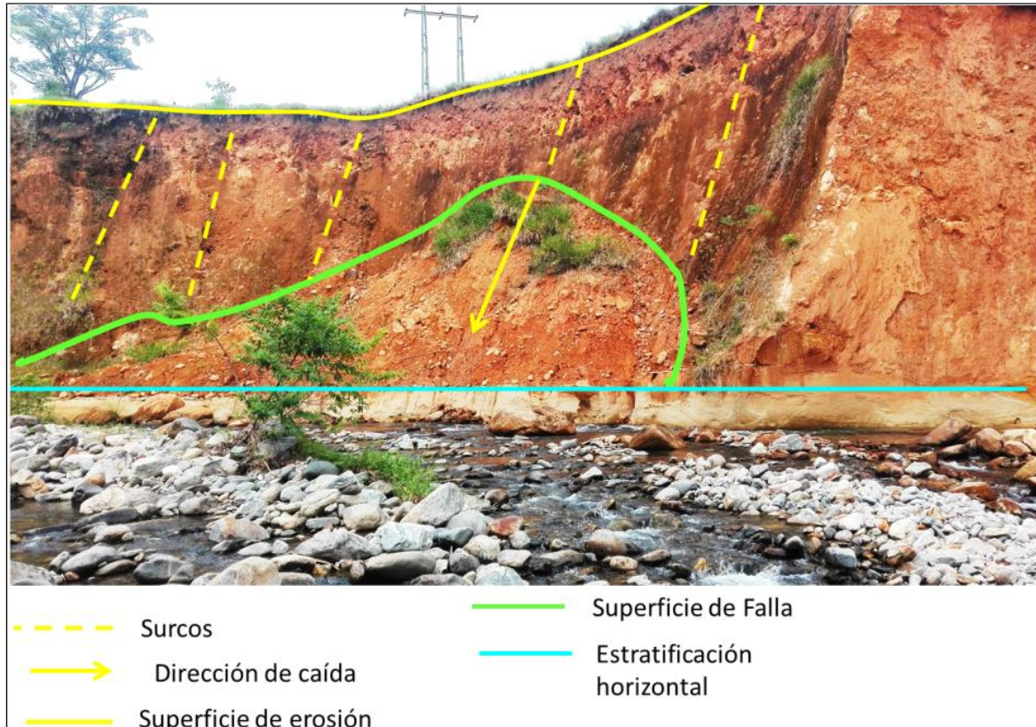
IMAGEN 4. INTERPRETACIÓN DE SOCAVAMIENTO LATERAL DEL RIO DONCELLO
