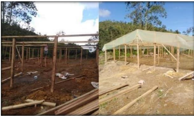
a. Construcción de la sala piloto de transformación de residuos orgánicos.
