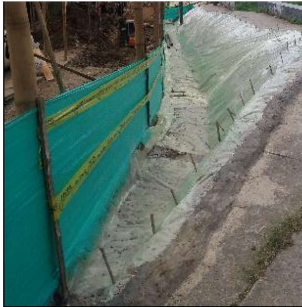
Ilustración 12. Señalización perimetral de la obra
