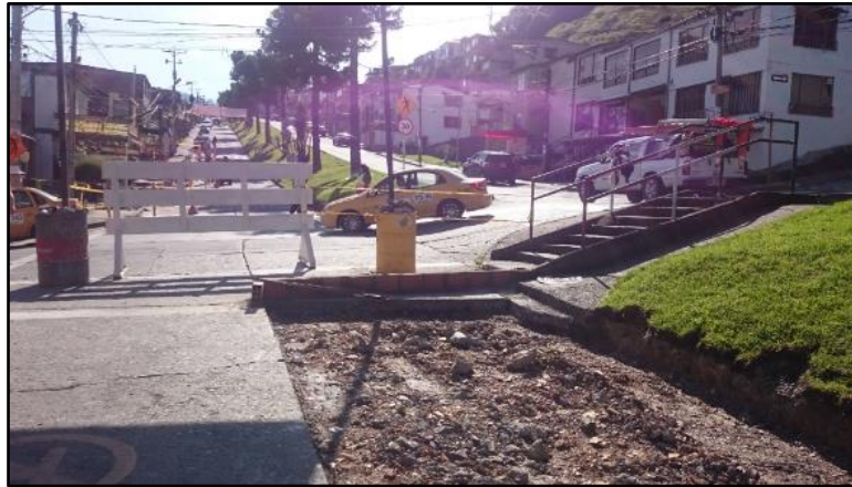
Ilustración 11. Cordón para control de aguas lluvias
