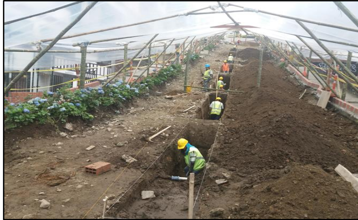
Ilustración 13. Hiladeros y excavación manual red principal
