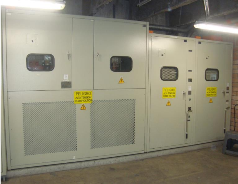
Figura 3. Subestación 1250 KVA
