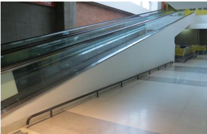
Figura 5. Sistema de transporte dos rampas
