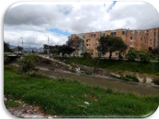
Imagen 6. Disposición inadecuada de Residuos Tramo III. Fuente: Autora (2018)
