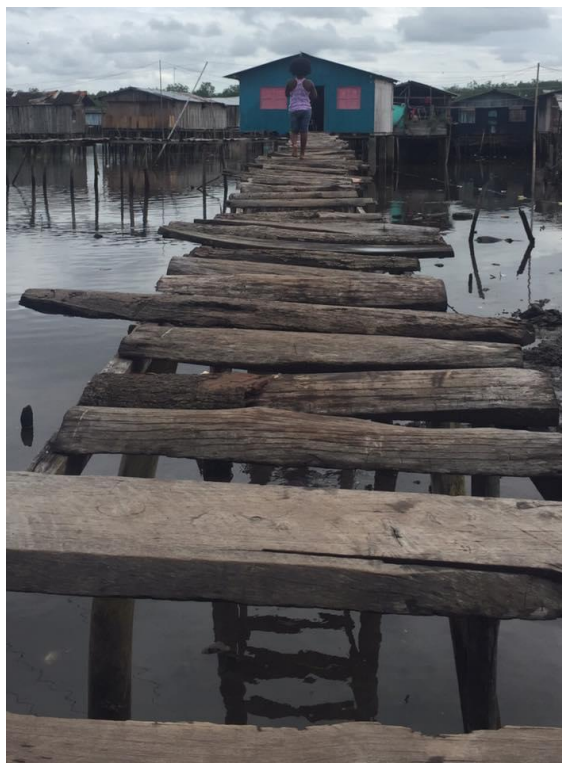
Figura 11. Vivienda y puente palafítico. Barrio Familias en Acción Tumaco (fuente propia).
