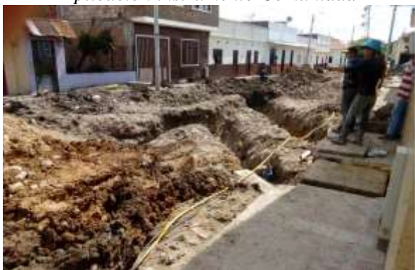
Obras de acueducto y alcantarillado municipal
