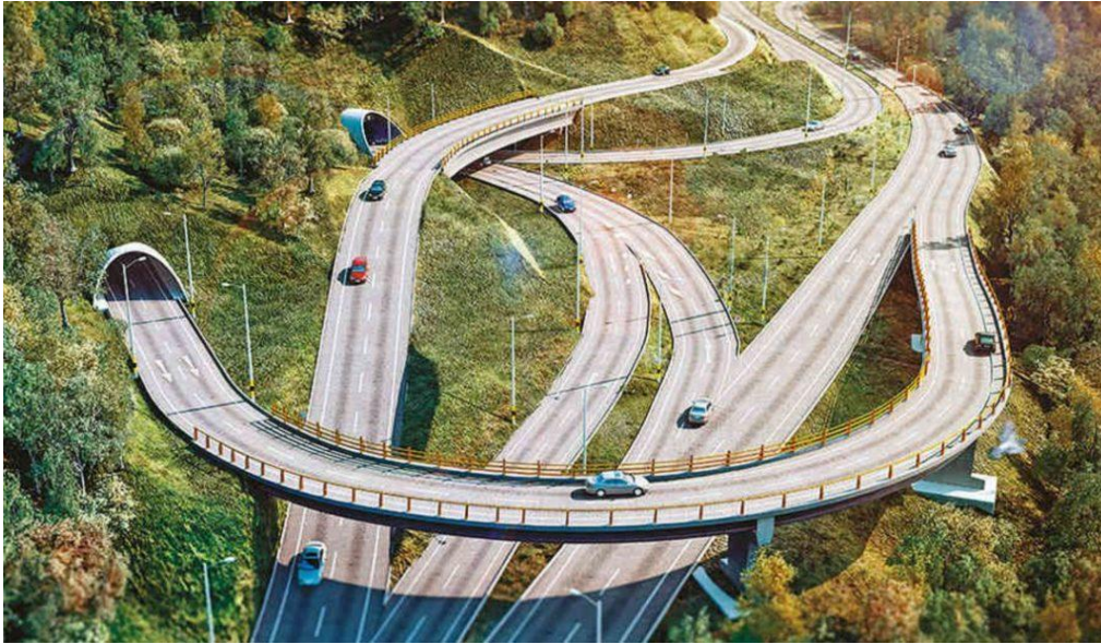
Ilustración 8: Túnel de Oriente
