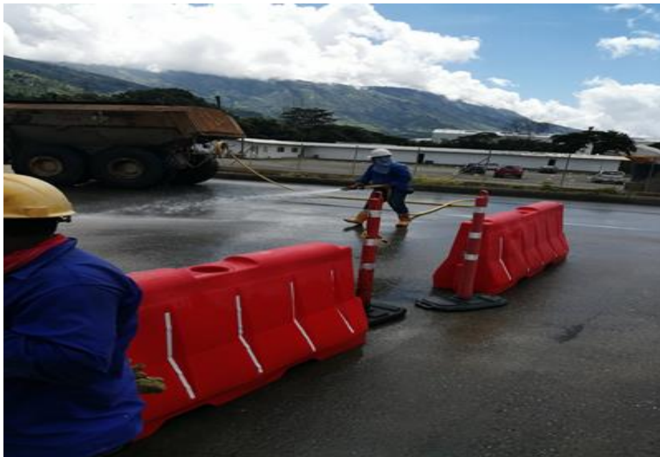
Fotografía 4. Lavar la entrada para evitar contaminación por partículas en Mincivil.
