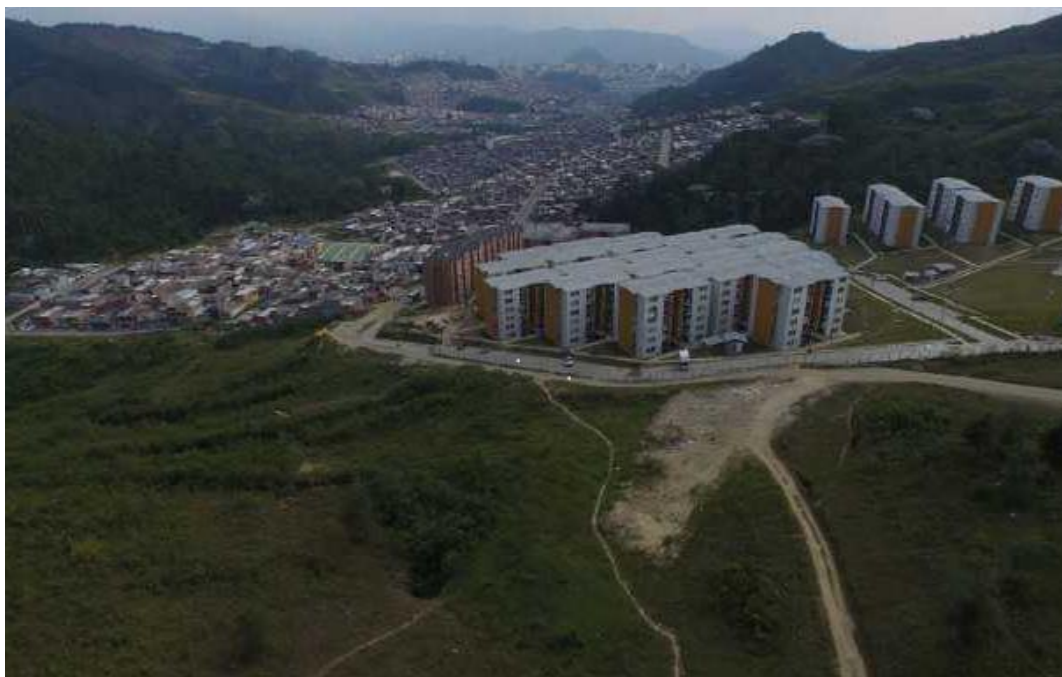
Figura 4. Panorámica Comuna Ciudadela del Norte
