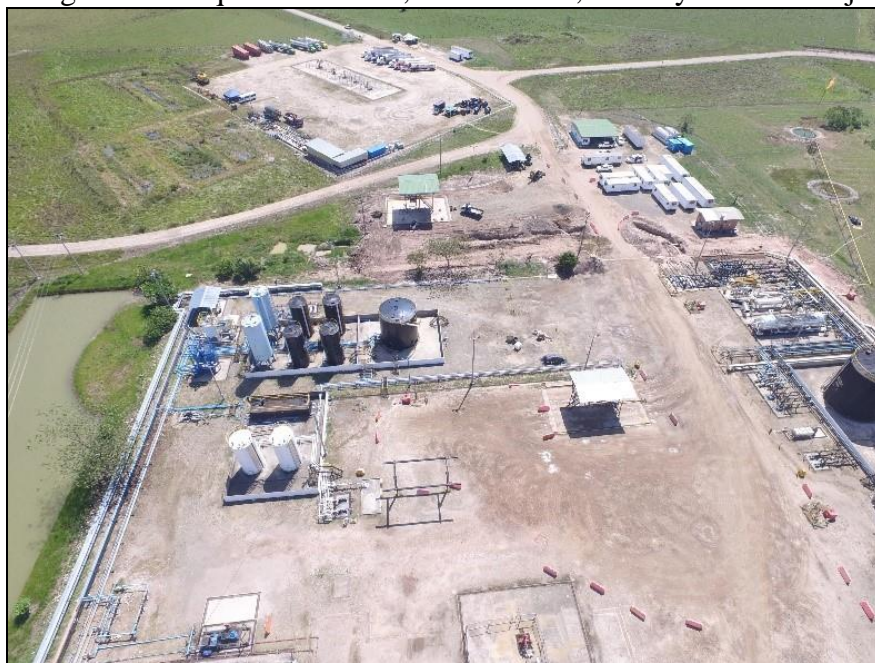
Imagen 22. Bloque Cabretero, PAD-Kitaro, Akira y Línea de flujo
