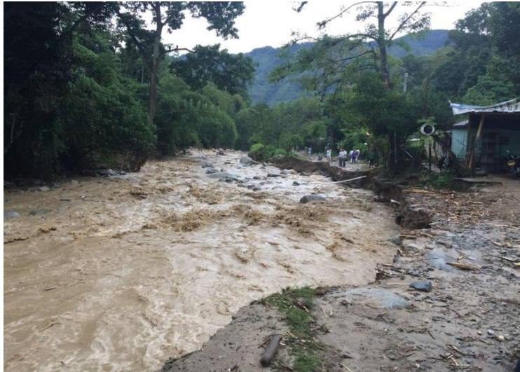
Figura 12. Foto: Perdida de vía por la creciente del río Rioblanco, Mayo 2018. Fuente: Propia, 2018.
