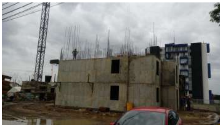
Registro No. 2. Y 3. Construcción del proyecto Torres de Salerno 2
