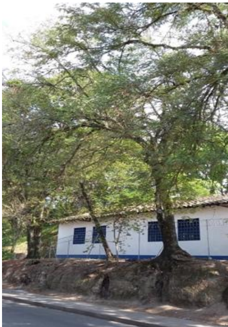
Figura 17. Árbol con riesgo de volcamiento por excavación
