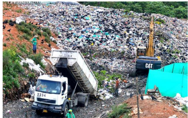
Imagen No. 4. Relleno sanitario (basuro) de Córdoba
