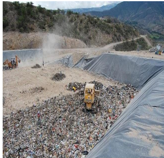
Imagen relleno sanitario de Yotoco.
