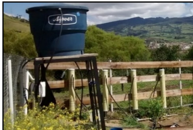
Figura 3. Montaje del sistema de filtros.
