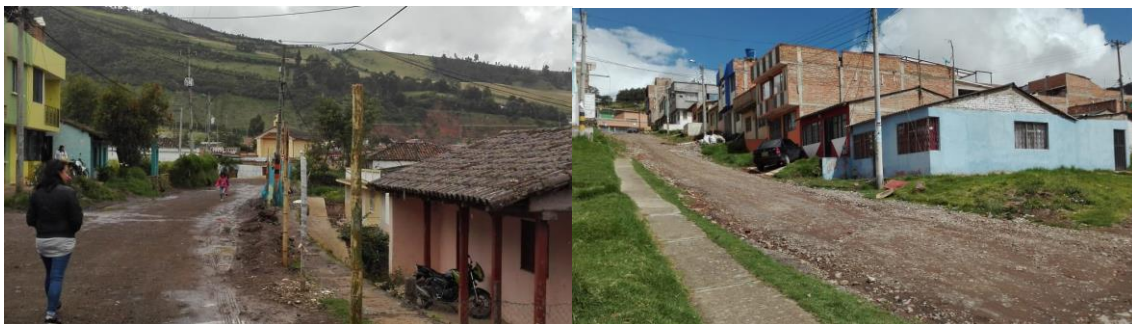
Figura 7. Estado actual de vías de acceso a barrios
