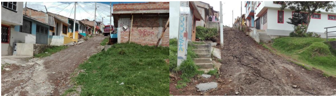
Figura 6. Estado actual de andenes
