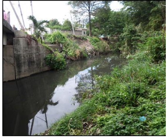
(2) Vista aguas arriba
