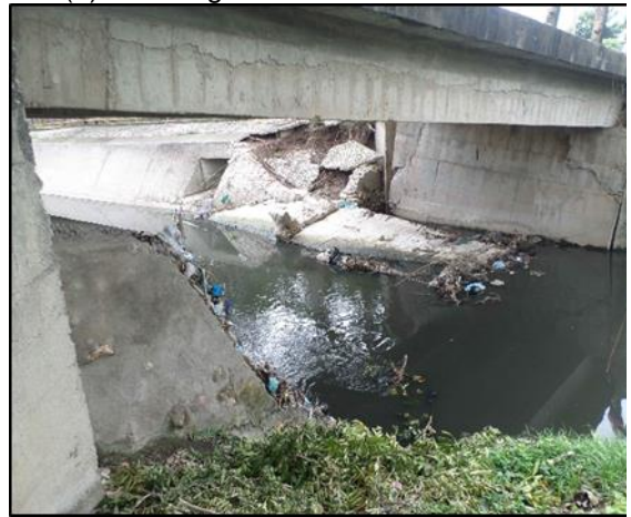
(4) Cara del puente aguas arriba
