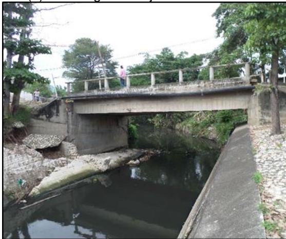
(3) Cara del puente aguas abajo
