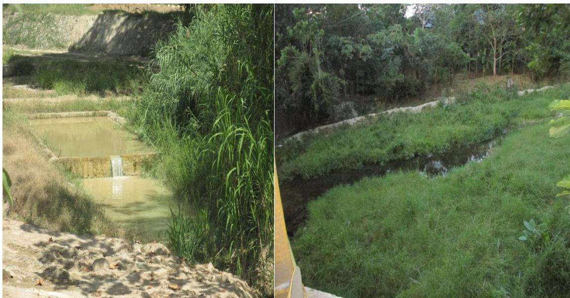
Figura 17 Represamiento y desvío del cauce del río
