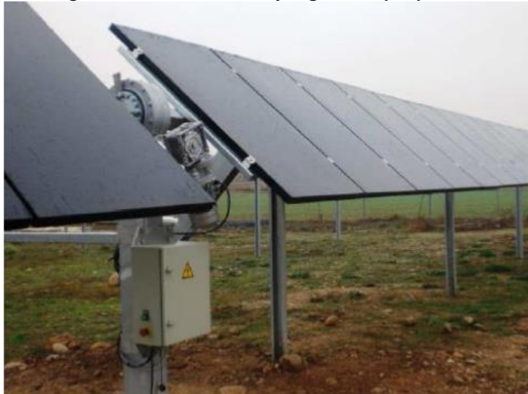
Figura 1-4: Estructura base y seguidores parque solar
