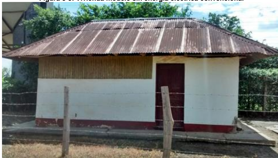
Figura 3-5: Vivienda modelo sin energía eléctrica convencional
