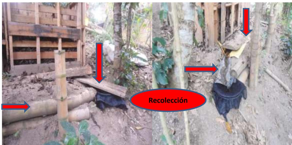
Figura 6. Canalización de lixiviados
