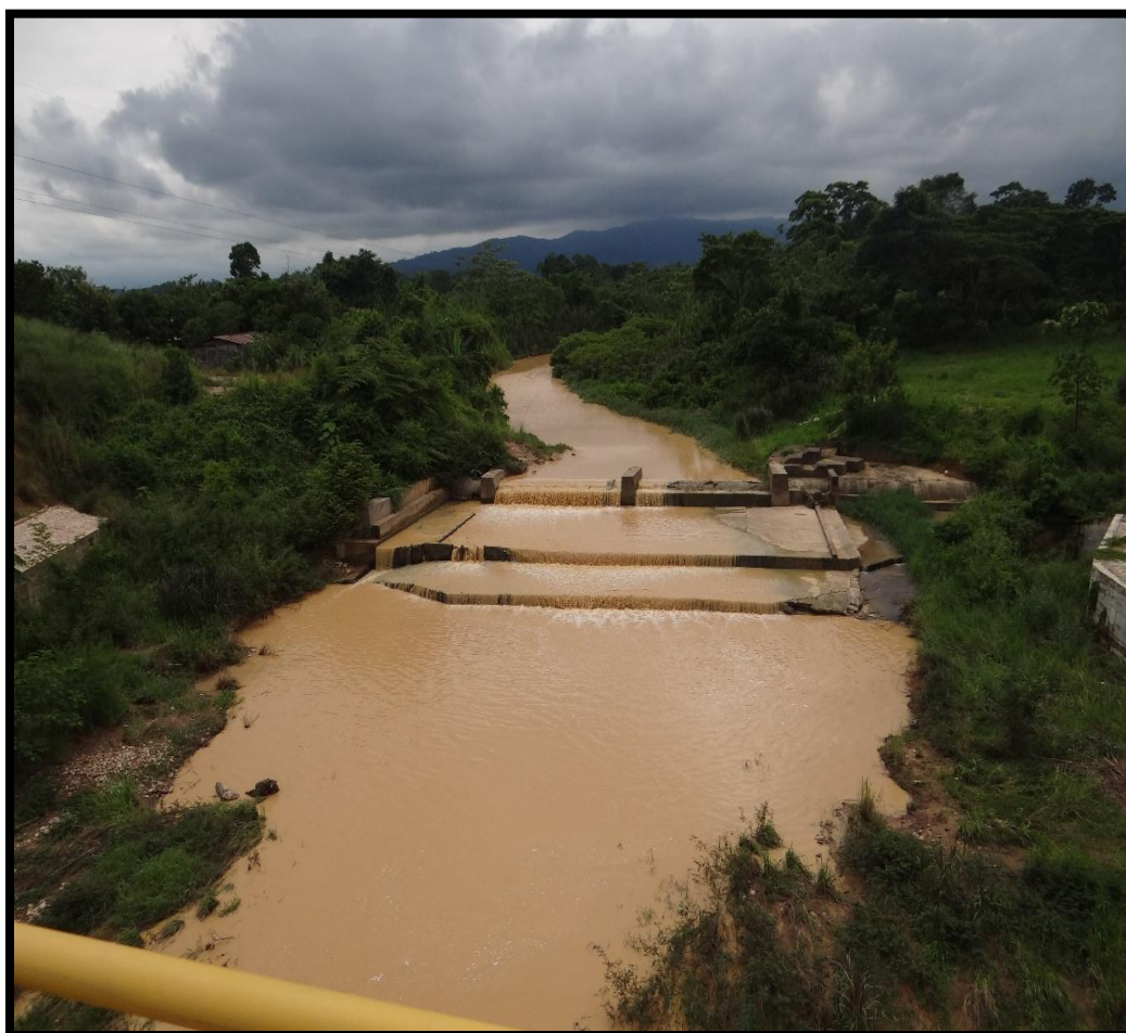
Figura 3. Represa de control de presión del agua en el distrito de riego del Rio Zulia.
