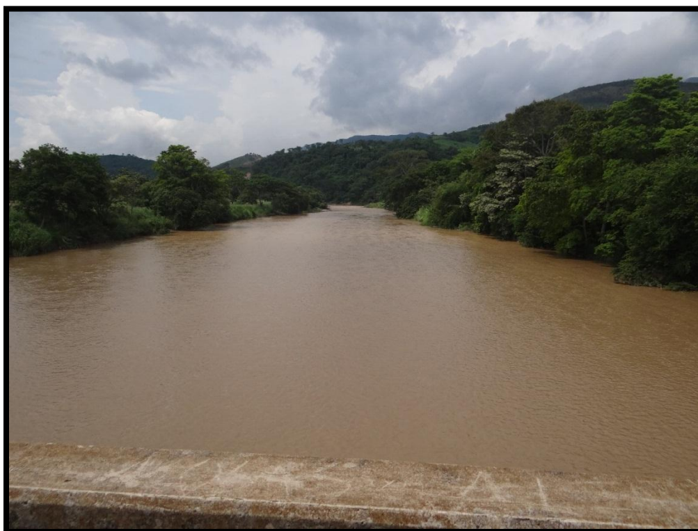
Figura 2. Panorámica del río Zulia, antes del desvío del agua hacia los canales del distrito de riego.
