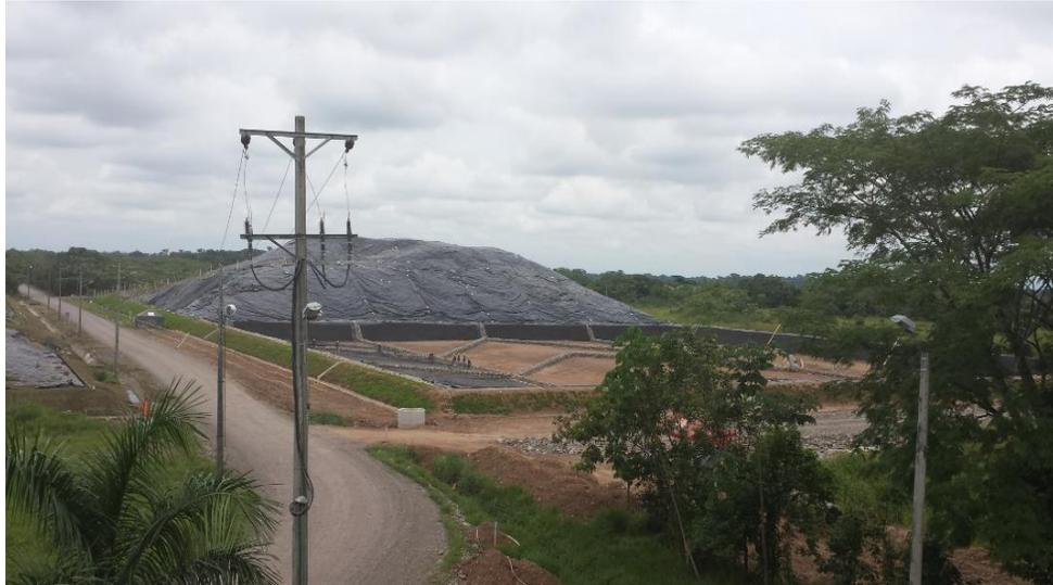
Figura 9: Vista de nueva celda, adecuación de manejo de lixiviados en espigas de pescado, manejo de taludes y zanjas perimetrales de agua lluvia y adaptación al tanque de lixiviados.
