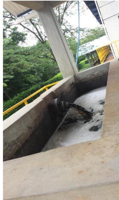
Figura 20-22: Vista de los tanques de procesos primarios, de igualación y proceso de coagulación – floculación de lixiviados
