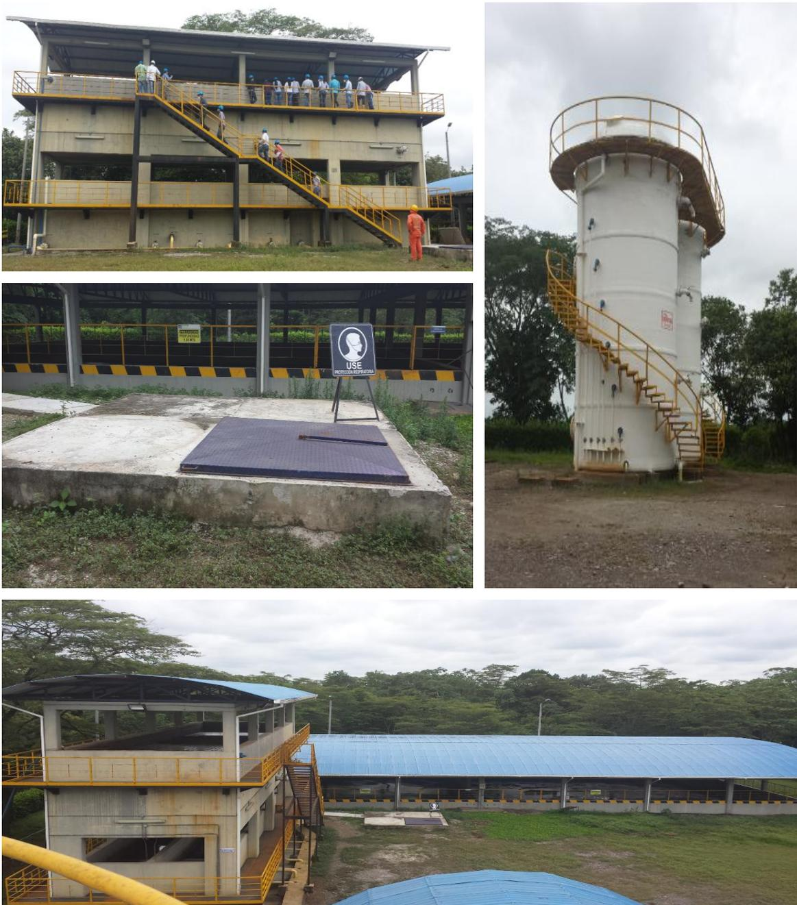
Figura 15-18: Vista de los tanques de procesos primarios, Piscinas de almacenamiento de lixiviados, reactores EGSB y vista lateral de tanques y piscinas.
