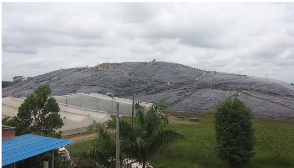
Figura 10: Vista de zona 1 de celdas colmatadas con cobertura, vista de chimenea tipo y vista de cobertura sintética.
