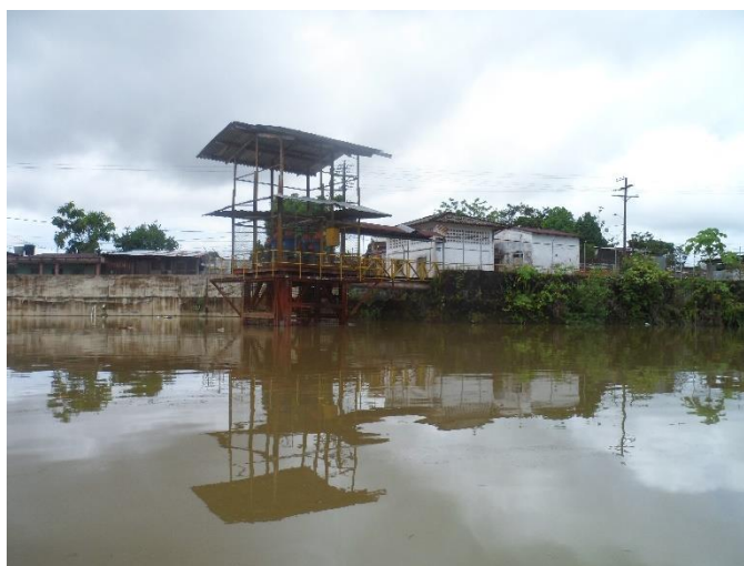
Imagen 1. Bocatoma acueducto de Quibdó
