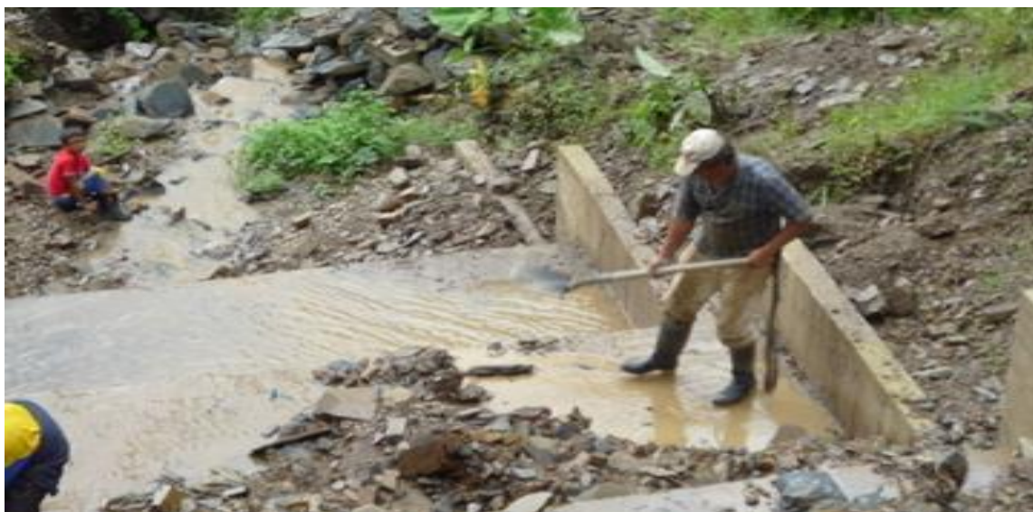
Foto 9. Nacimiento de la Quebrada Las Brujas, intervención fuerte
