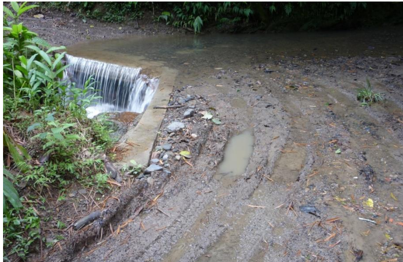
Foto 19. Estación 1 de muestreo, intervención construcción vía, esta foto fue tomada en abril, se evidencia el amento de caudal en este punto.
