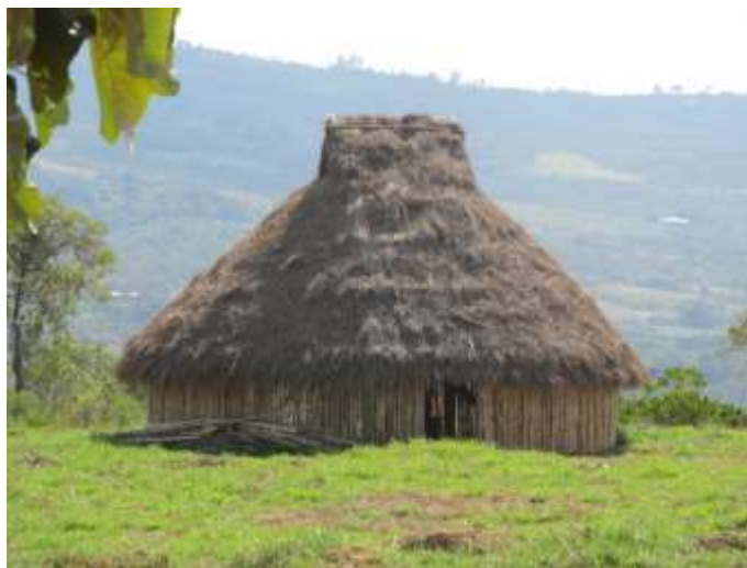
Fotografía 5-9: Cubierta en fibras naturales, con soportes y paredes exteriores en guadua. Barichara, Santander.
