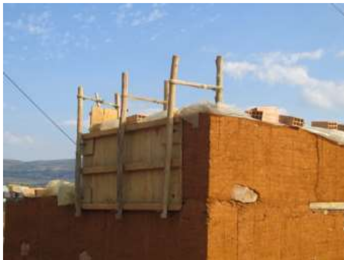
Fotografía 5-3: Detalle del tapial en la construcción de vivienda en tapias pisada, Barichara - Santander
