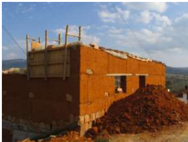
Fotografía 5-2: Construcción de vivienda en tapia pisada, Barichara - Santander
