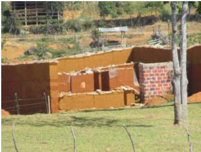
Fotografía 5-1: Construcción de una vivienda en tierra, Barichara - Santander
