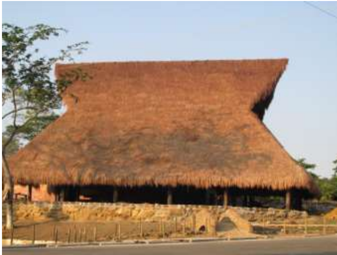
Fotografía 5-10: Cubierta en fibras naturales y entramado en guadua. Socorro - Santander
