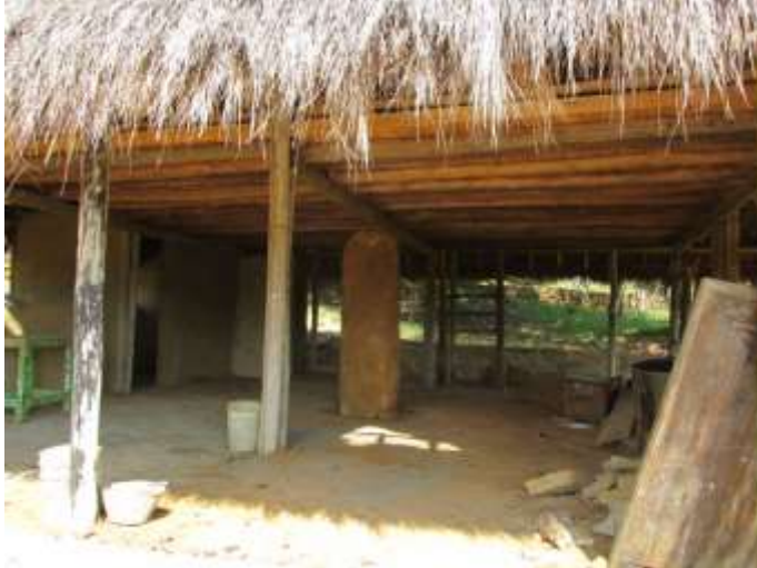
Fotografía 5-8: Uso de madera, fibras naturales en cubierta y columnas de piedra en la estructura, Barichara - Santander
