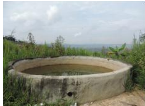
Imagen 23: Pozo construido por el señor Luis Beltran.
