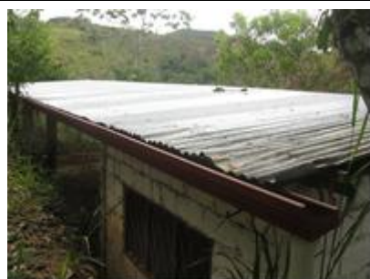
Imagen 6: Galpón del techo de un agua.
