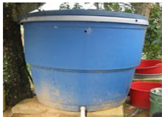
Imagen 12: Tanque con capacidad de 1.000 litros.
