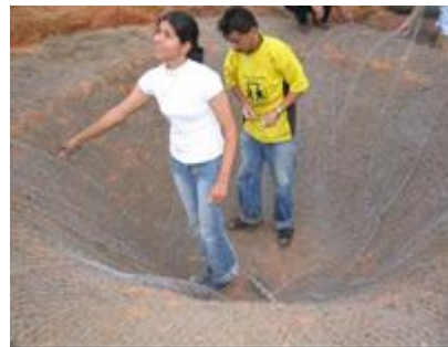
Imagen 20: Instalación de Malla.
