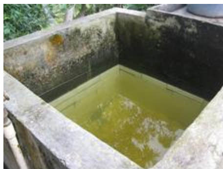
Imagen 17: Tanque del lavadero.
