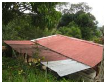
Imagen 7: Garaje del techo de dos agua.
