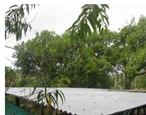
Imagen 5: Apriscos del techo de un agua.
