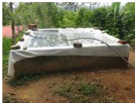
Imagen 15: Tanque con capacidad de 14.000 litros.
