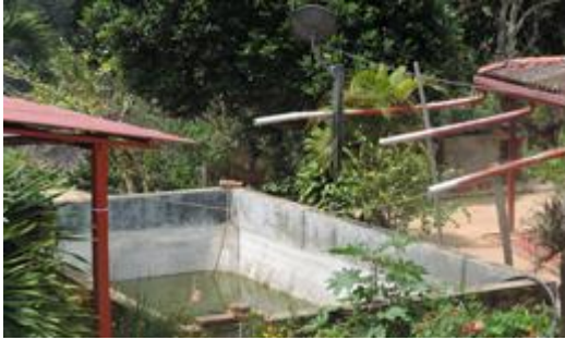
Imagen 1: Tanque con capacidad de almacenar 84.000 mil litros de agua lluvia.
