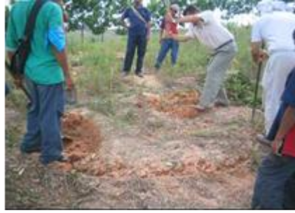
Imagen 18: Trazado de excavación pozo en ferrocemento.
