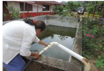
Imagen2: Adaptación artesanal para la distribución del agua lluvia captada en tanques de depósito y reserva.
