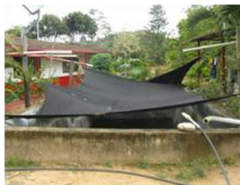
Imagen 13: Tanque con capacidad de 84.000 litros.
