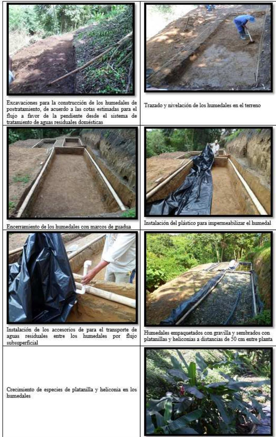
**Figura 20.** Instalación de los humedales de flujo subsuperficial para el postratamiento de aguas residuales domésticas en la Estación Central Naranjal
