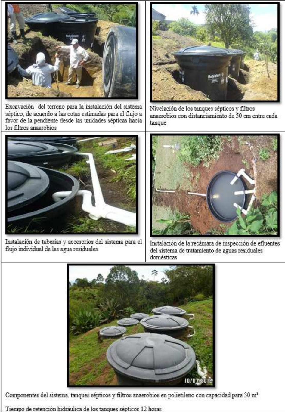
**Figura 19.** Instalación del sistema de tratamiento de aguas residuales domésticas en la Estación Central Naranjal
