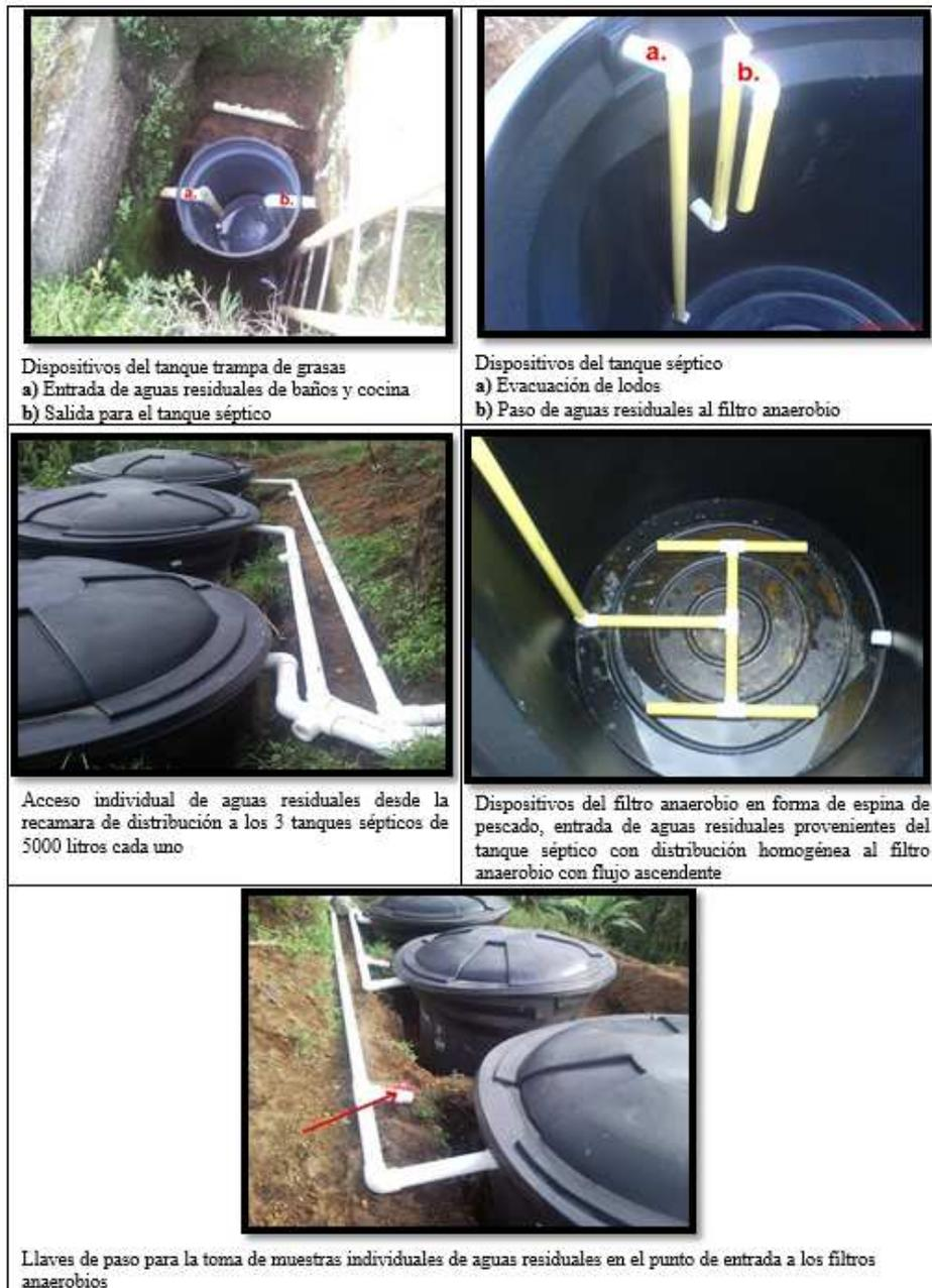
**Figura 18.** Dispositivos del sistema de tratamiento de aguas residuales domésticas.
