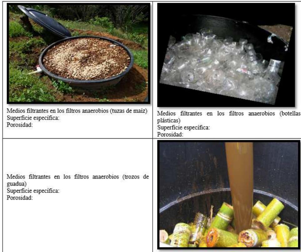
**Figura 16.** Medios de soporte utilizados en los filtros anaerobios del sistema de tratamiento de aguas residuales domésticas en la Estación Central Naranjal
