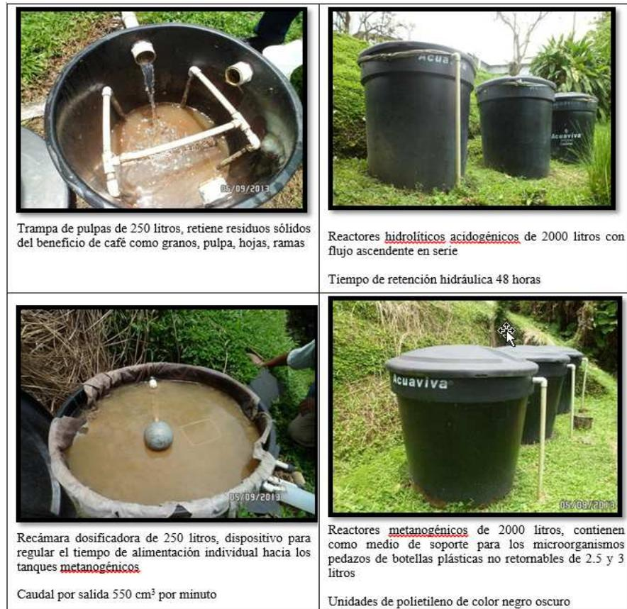
**Figura 23.** Sistema modular para el tratamiento anaerobio de aguas residuales del beneficio de café.
