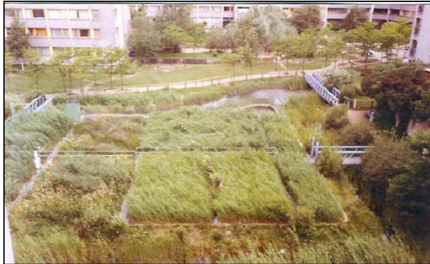
Figura 8. Tratamiento de aguas grises mediante suelo húmedos en Alemania. (Allen, L.,Smith, J., Paloniappan, M., 2010)
