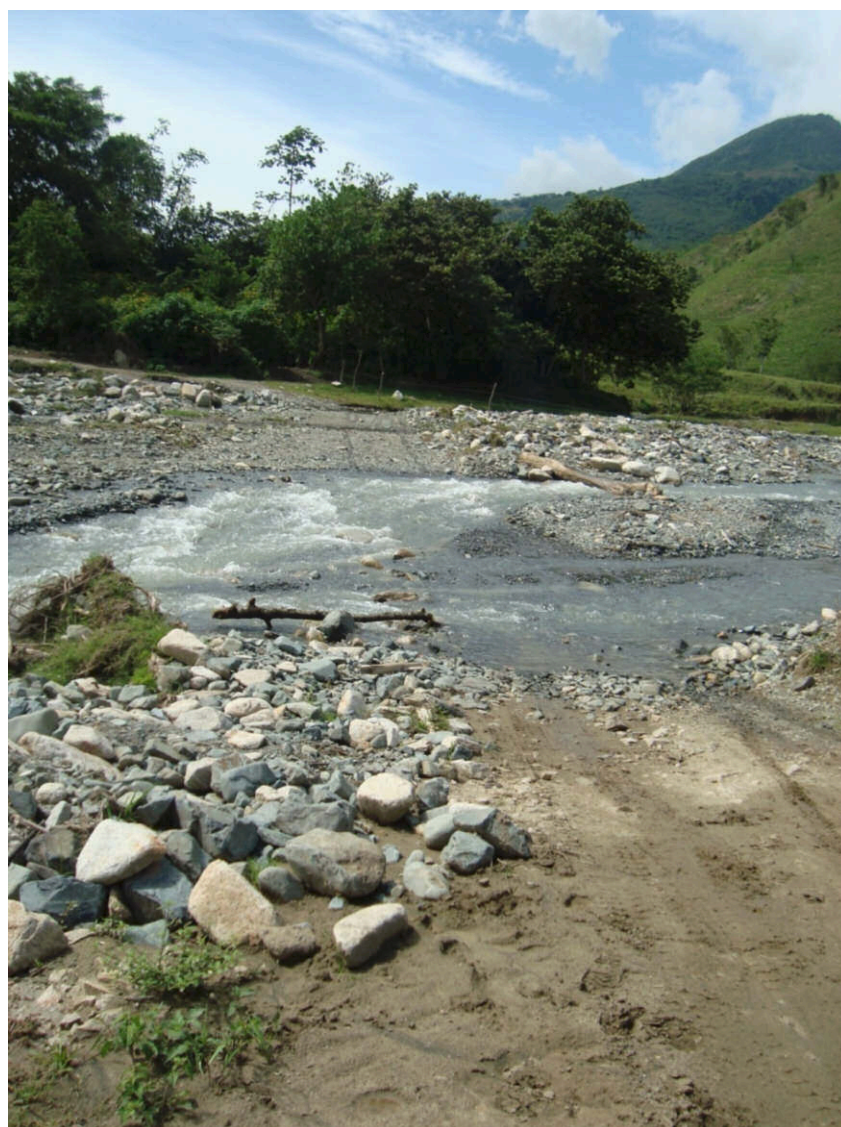
Imagen 1. Vía hacia “San Mateo”. Se puede observar la ausencia de puente que atraviese el río, por lo cual, cuando éste se crece el predio queda incomunicado.
