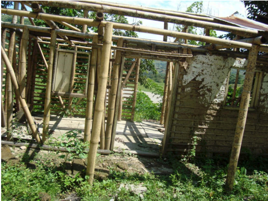
Imagen 7. Rancho en construcción
