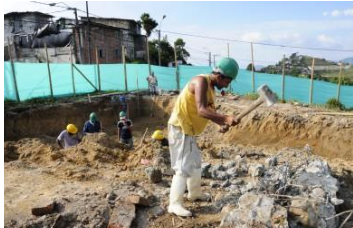
Figura 10: Construcción de apartamentos en la ladera de La Avanzada ( www.lapatria.com marz.13 de 2013)
