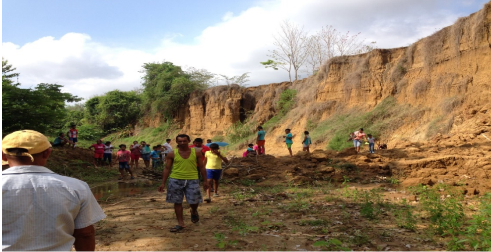
Ilustración Anexo 3: Comunidad iniciando labores de retiro de masa de tierra que obstaculiza el flujo de agua en 8 abril 2018
