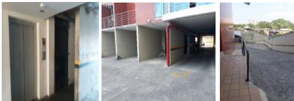
Figura 3-5: Unidad de Almacenamiento y ruta de evacuación de residuos sólidos.
