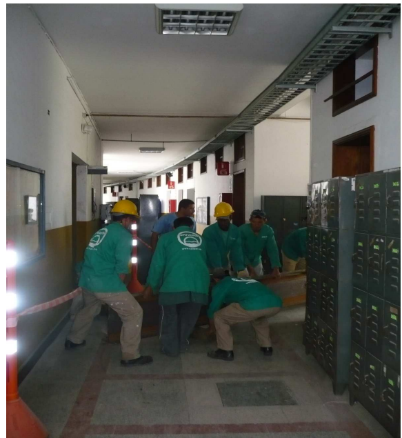
Obreros cargando viga metálica en pasillo de la Institución
