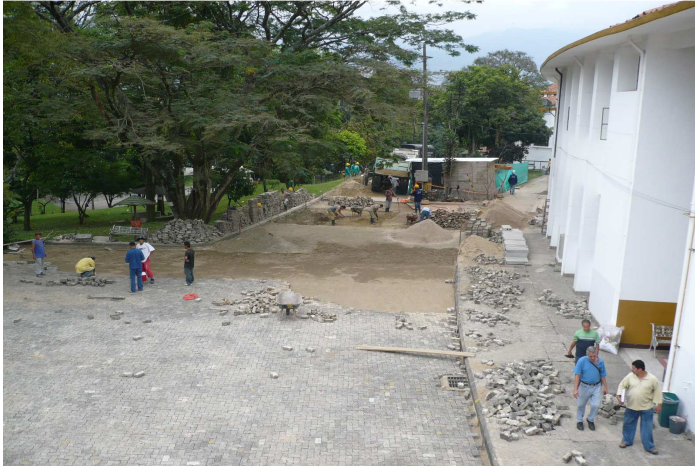
Reparación de zona de parqueadero
