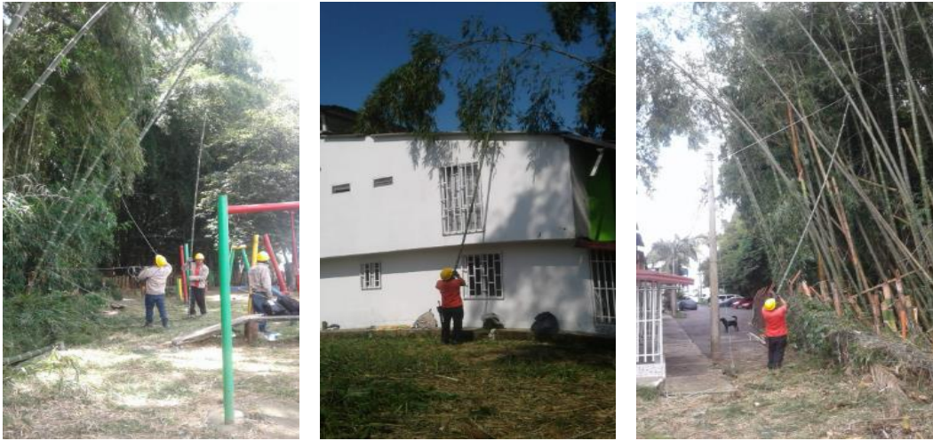
Figura 36. Control de caída de culmos
