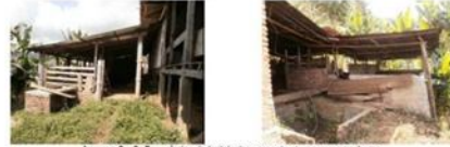
Imagen 2 y 3: Panorámica de instalaciones y estructuras como cocheras.
