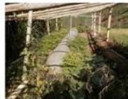
Imagen 5: Panorámica del biodigestor utilizado para el tratamiento de las aguas residuales.
