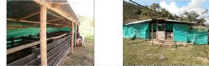
Imagen 2 y 3: Panorámica de instalaciones y estructuras como cocheras.
