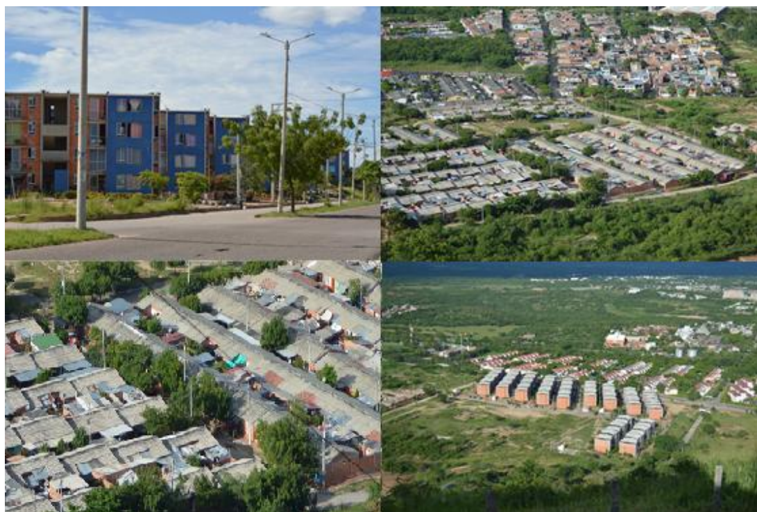
Imagen 12. Fotos exteriores de contexto del Barrio Corazón de Cundinamarca en la actualidad. Fuente: Elaboración propia
