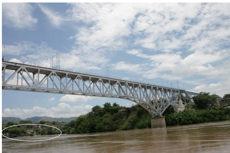
Imagen 13. La zona demarcada corresponde al sector de la 15, allí se desborda el Río Magdalena y muchos habitantes fueron reubicados en Corazón de Cundinamarca.
