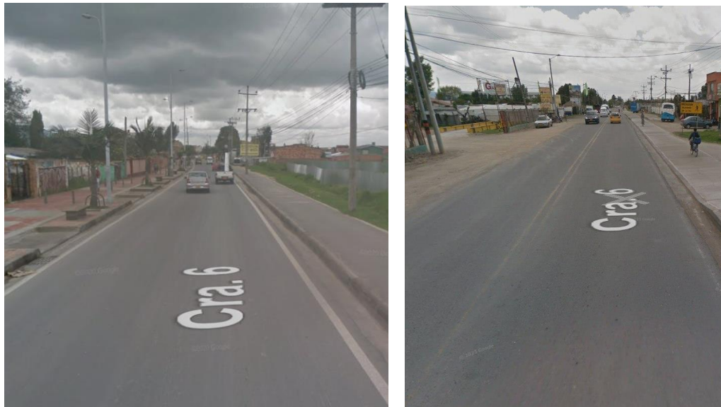
Ilustración 7 . Falta de demarcación de ciclo rutas. (Fuente: Google Street View)
