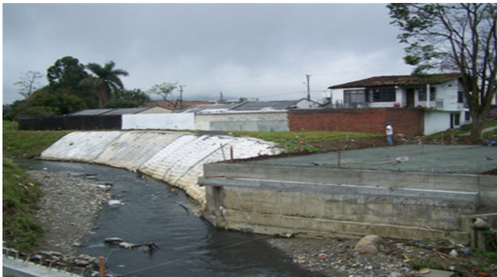
Fuente. Registro fotográfico. Quebrada Frailes.
