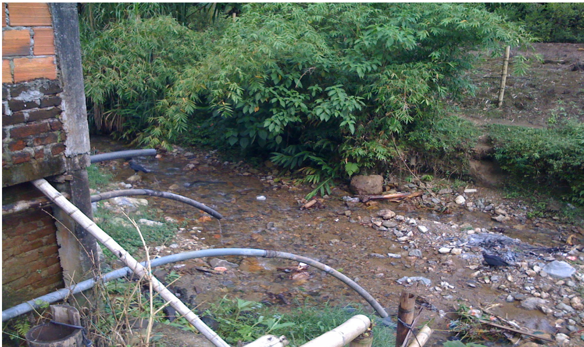
Gráfico 20. Disposición inadecuada de Aguas Residuales y de Escorrentía
