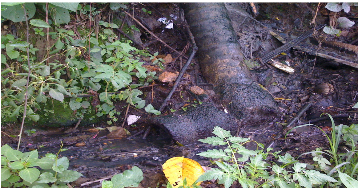
Gráfico 21 .Disposición inadecuada de Aguas Residuales Domésticos. Ladera Norte B. El Japón
