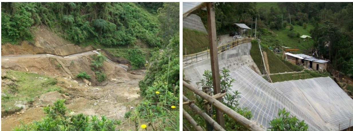
FIGURA 73. OBRAS DE ESTABILIDAD EN CORRECCIÓN, SECTOR LA CURVA DEL MICO
