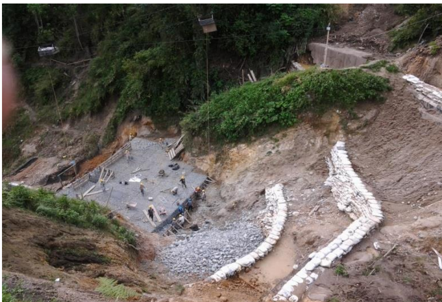
FIGURA 74. OBRAS DE GAVIONES Y DISIPADORES DE ENERGÍA EN EL LECHO DEL CERRO DE ORO
