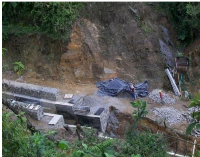
FIGURA 75. GAVIONERIA SOBRE EL LECHO DE LA MICRO CUENCA, SECTOR LA CURVA DEL MICO
