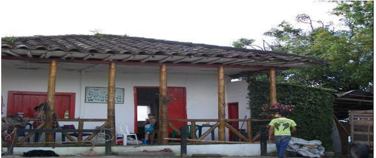
FIGURA 36: CASAS DE BAHAREQUE, CON TECHO DE TEJA, SIN CANALES, SECTOR CERRO DE ORO
