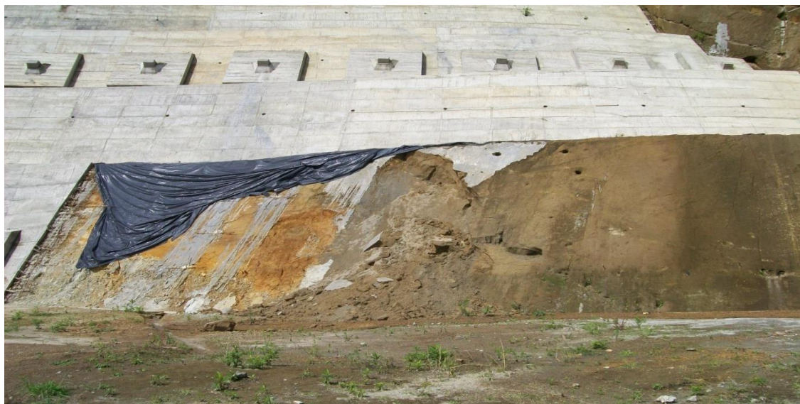
FIGURA 53. OBRA POR TERMINAR, SECTOR CERRO DE ORO
