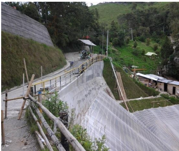
FIGURA 78. OBRAS DE ESTABILIDAD QUE FUERON CORREGIDAS, SECTOR LA CURVA DEL MICO
