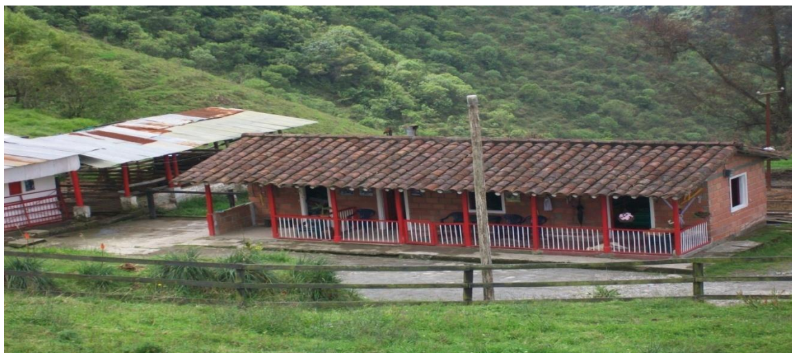
FIGURA 56. FALTA DE CANALIZACIÓN EN TECHOS DE VIVIENAS, SECTOR CERRO DE ORO.
