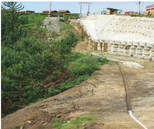
FIGURA 65. OBRAS SECTOR CERRO DE ORO, CANALIZACIÓN DE AGUAS
