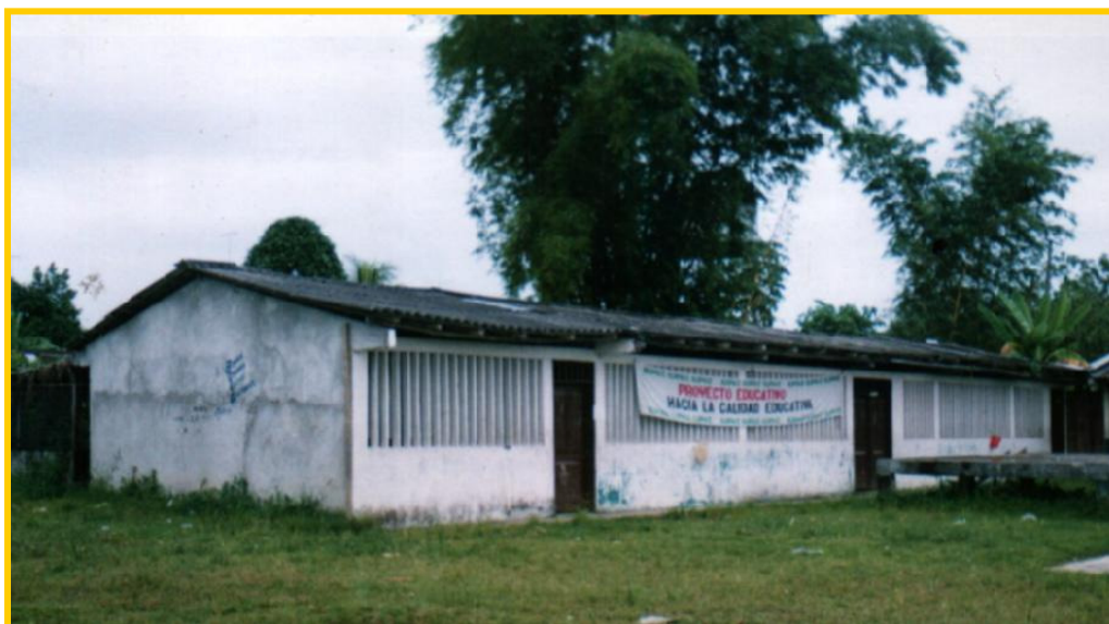
Figura 42. Ampliación aula múltiple Colegio ILIPAC
