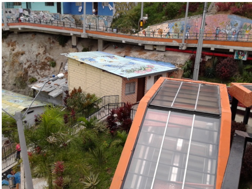
Fotografía 7: Escaleras eléctricas, comuna 13 de Medellín. Archivo personal investigadora.
