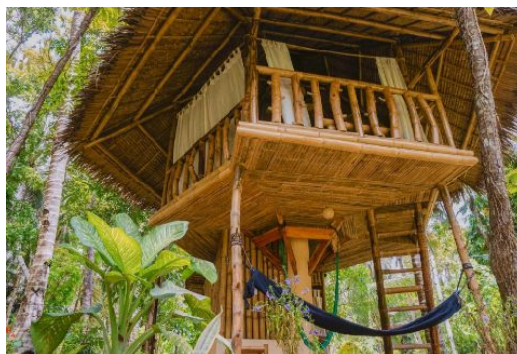
Imagen. Estructura para ecolodge
