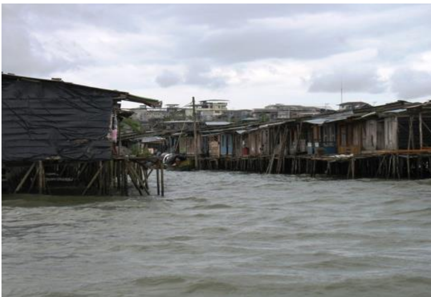
Figura 17. Viviendas palafíticas en condición de pobreza en Buenaventura
