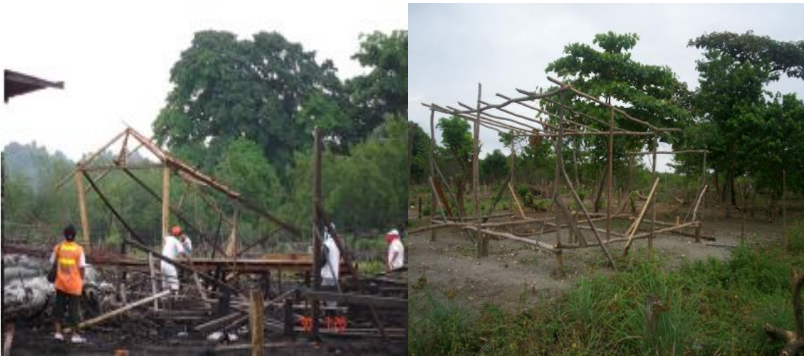
Figura 10. Construcción de vivienda palafítica en zona de estero en Tumaco
