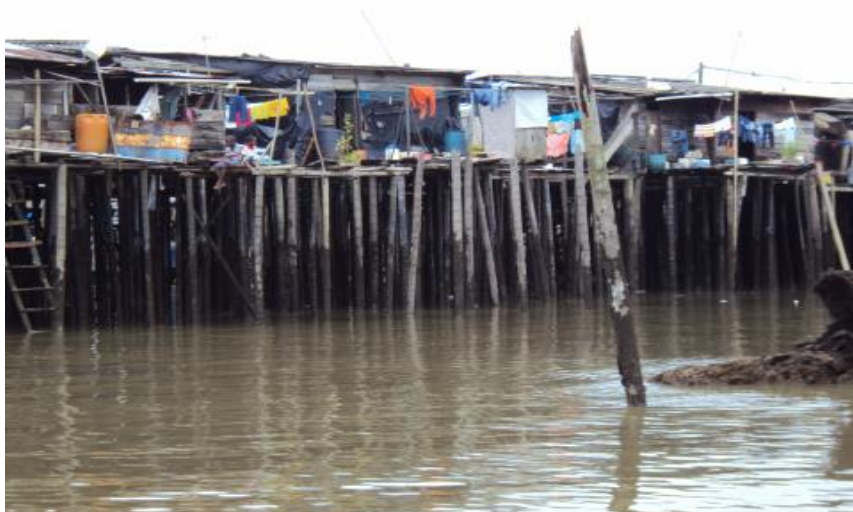
Figura 3. Viviendas palafíticas en Buenaventura
