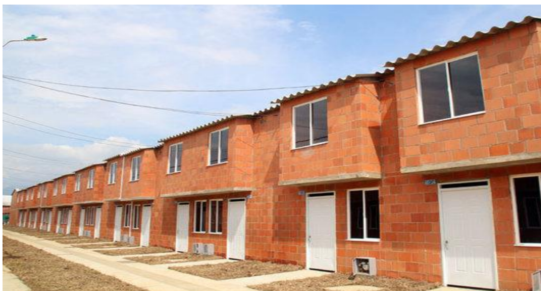
Figura 45. Vivienda gratuita. Barrio Llano Verde, Distrito de Aguablanca en Cali
