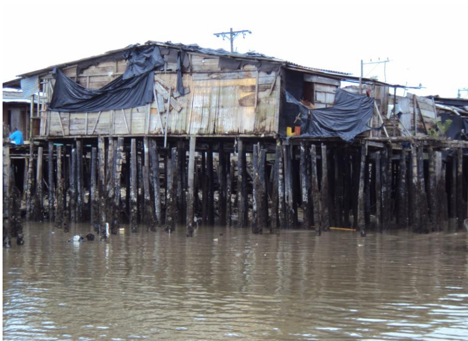
Figura 8. Vivienda palafítica en el barrio Viento Libre en Buenaventura
