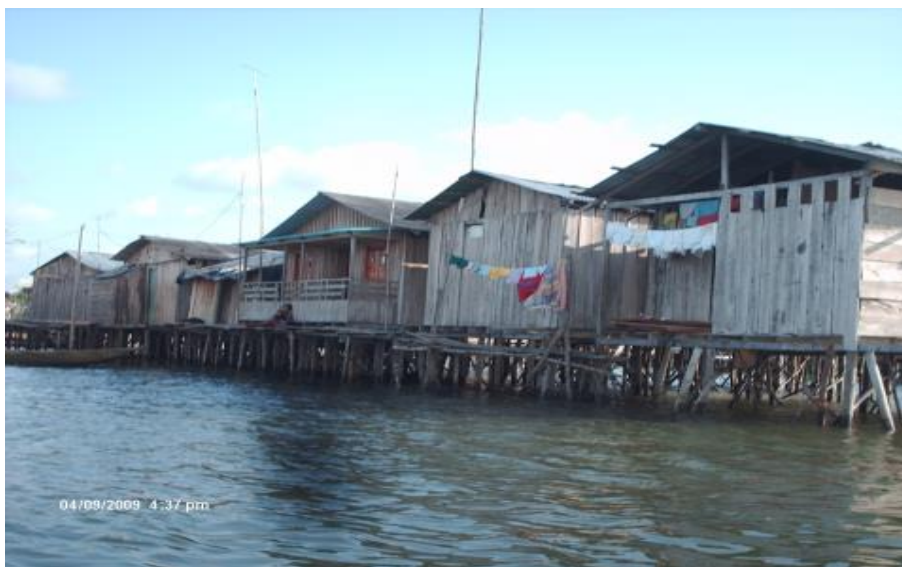
Figura 7. Vivienda palafítica en el barrio Viento Libre en Buenaventura
