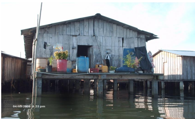
Figura 29. Vivienda paralitica construida de manera mixta, en madera y en cemento
