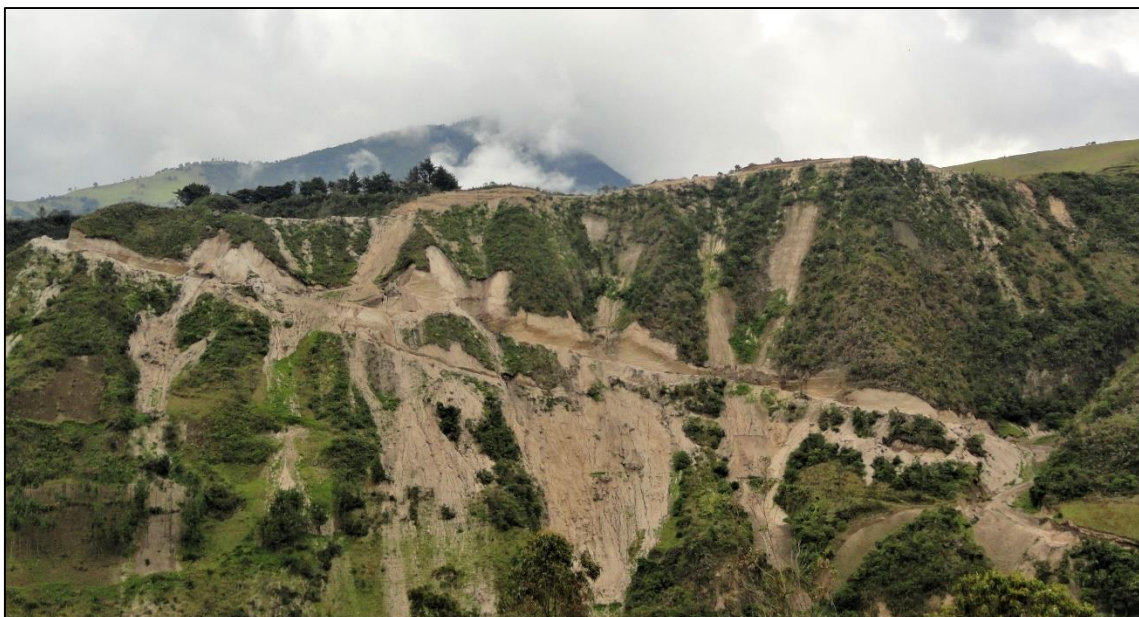
Figura 34. Numerosos deslizamientos traslacionales y golpes de cuchara causados por la construcción de vías en zonas de alta pendiente. Corregimiento de Tajumbina. Fotografía: Narváez (2011)
